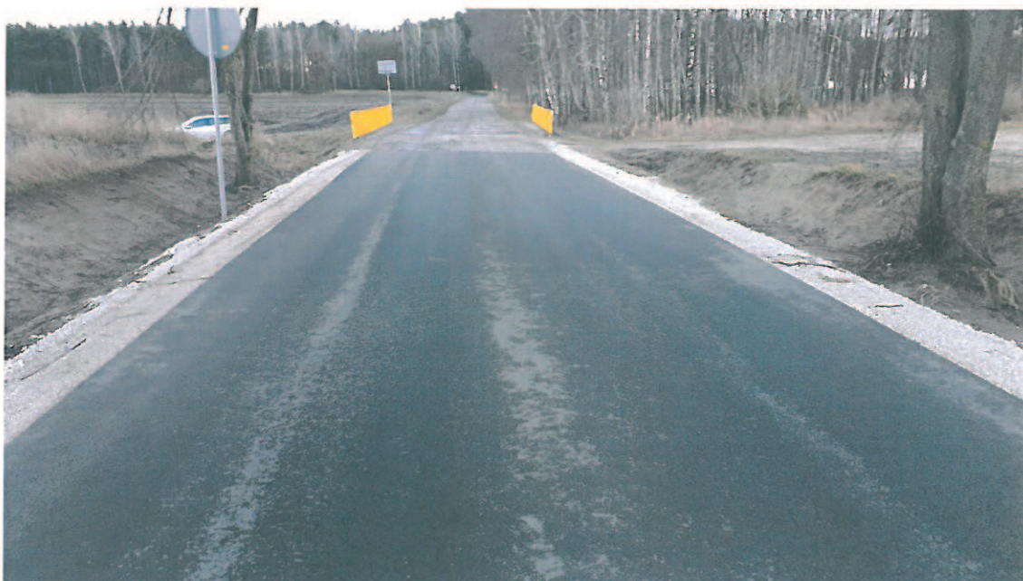
Fot. 4. Widok na dojazd do obiektu od strony m.Rejna.
