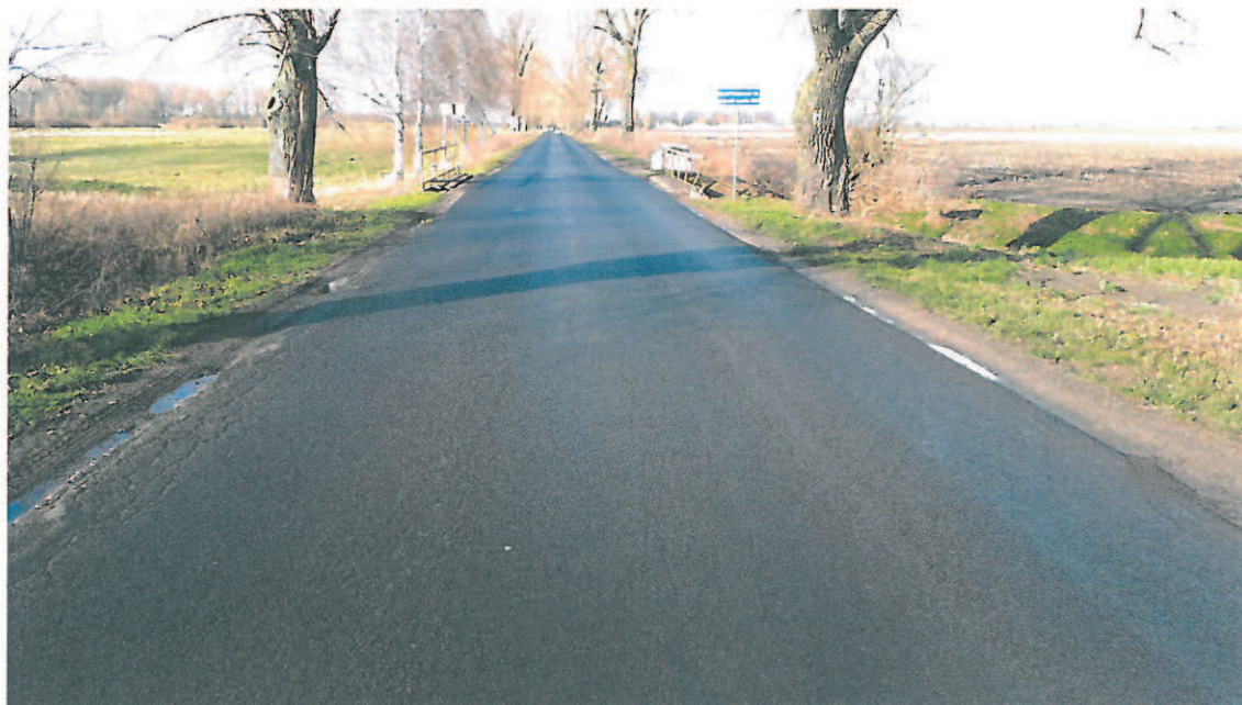
Fot. 4. Widok na dojazd do obiektu od strony m.Szarlej.
