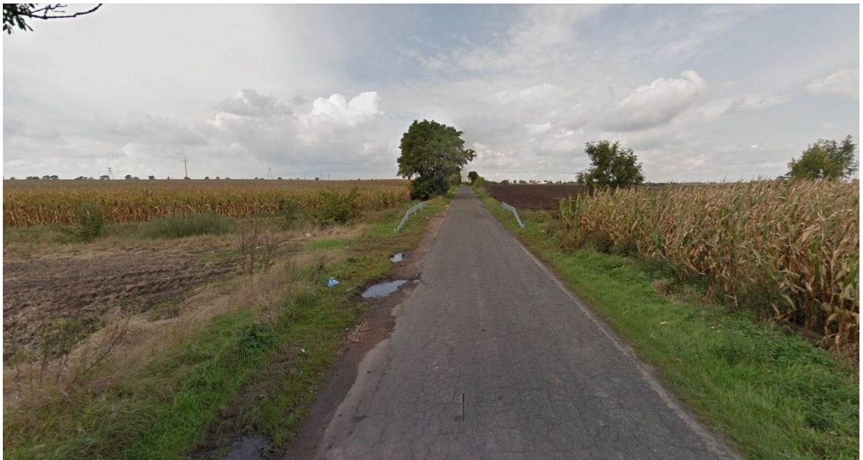
Fot. 2. Droga powiatowa przy pójściu przez pola uprawne – widoczne zdegradowanie jezdni
