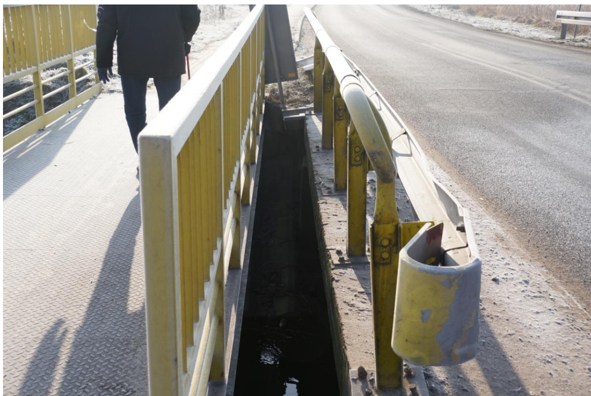
Zdjęcie 4. Deformacja barier drogowych na moście
