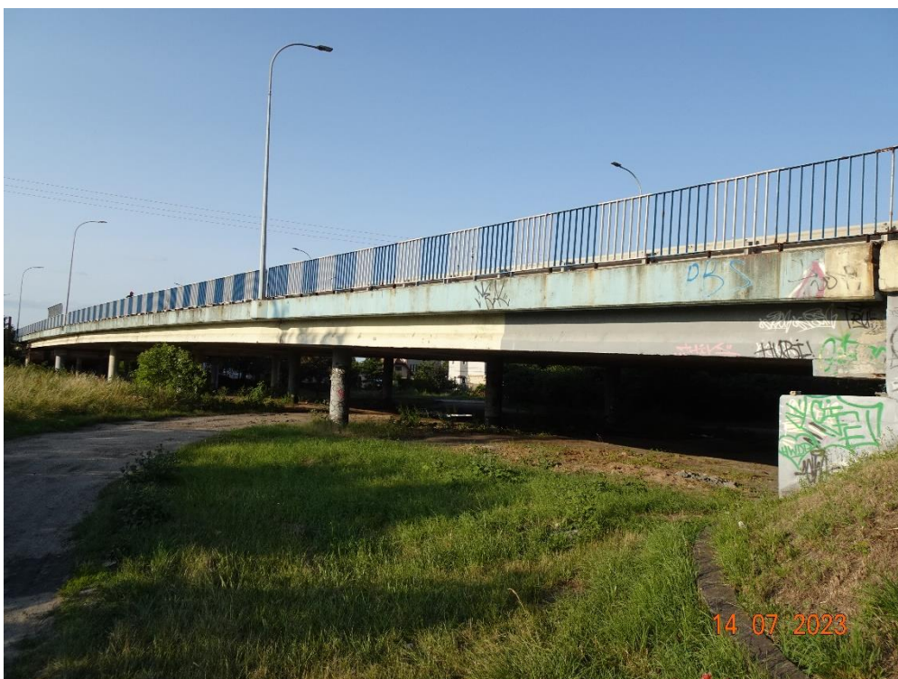
Fot. 2. Widok obiektu z boku od strony zachodniej (strona prawa).
