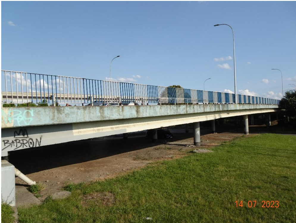
Fot. 1. Widok obiektu z boku od strony zachodniej (strona prawa).
