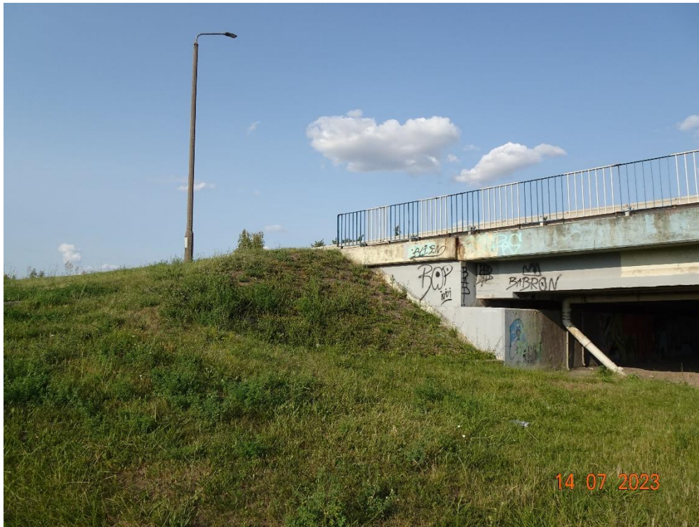
Fot. 22. Stożek skarpowy przy przyczółku nr 1, strona zachodnia.
