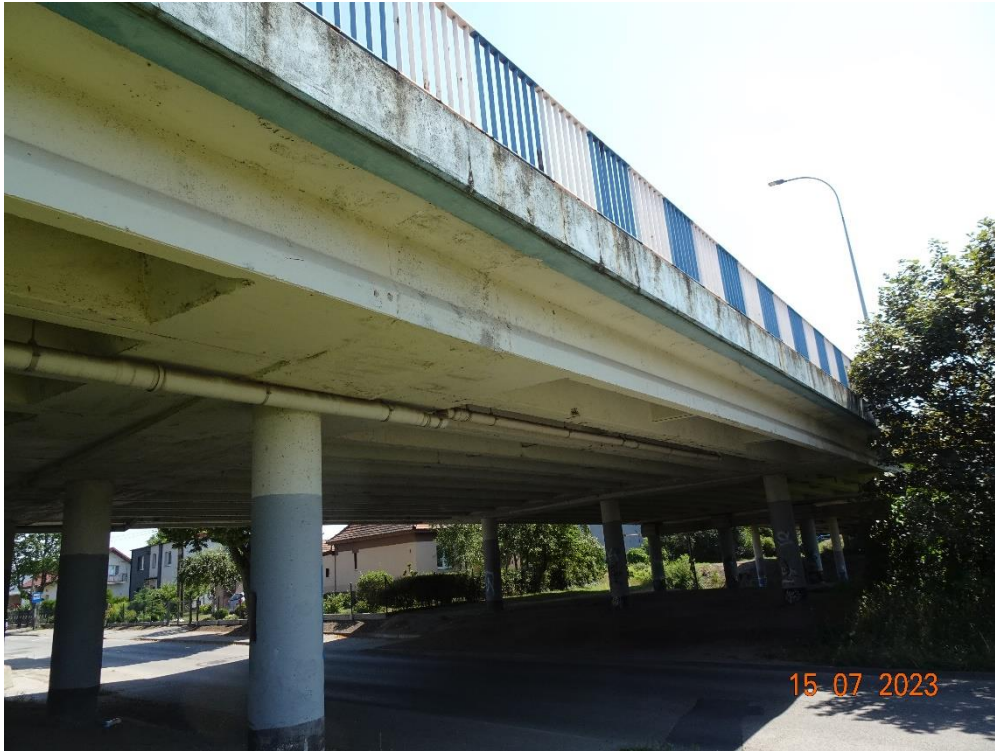
Fot. 3. Widok obiektu z boku od strony zachodniej (strona prawa), filary, przeszkoda (ul. Przybyszewskiego).
