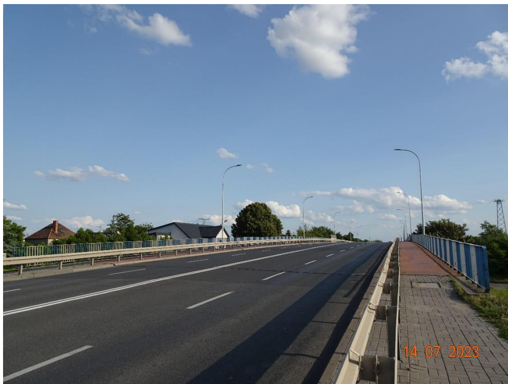
Fot. 29. Widok dojazdu od strony centrum.
