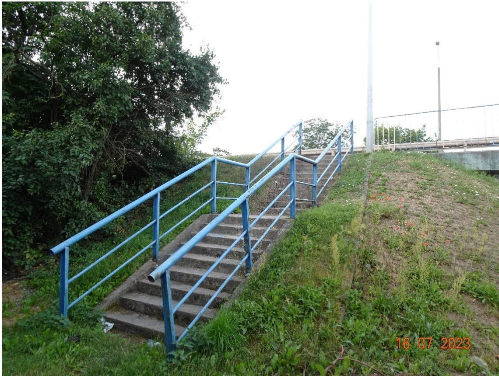
Fot. 25. Stożek skarpowy przy przyczółku nr 9, strona wschodnia; schody.
