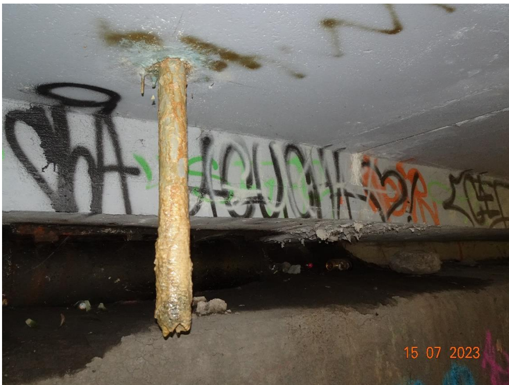
Fot. 79. Osady na sączku przy podporze nr 9 świadczące o niedostatecznym uszczelnieniu izolacji pomostu w miejscu połączenia z sączkiem.
