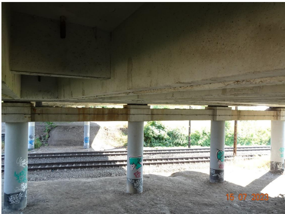
Fot. 18. Podpora nr 5.
