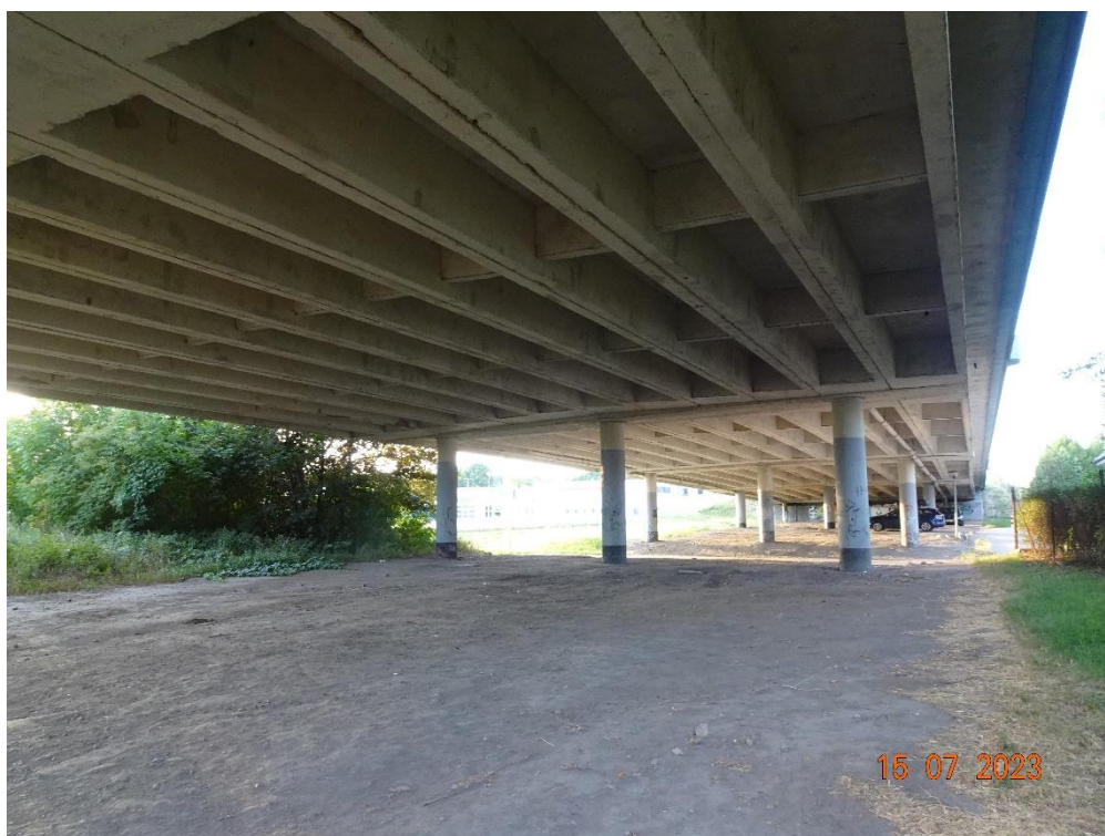
Fot. 10. Przęsło 4-5, podpora nr 4.
