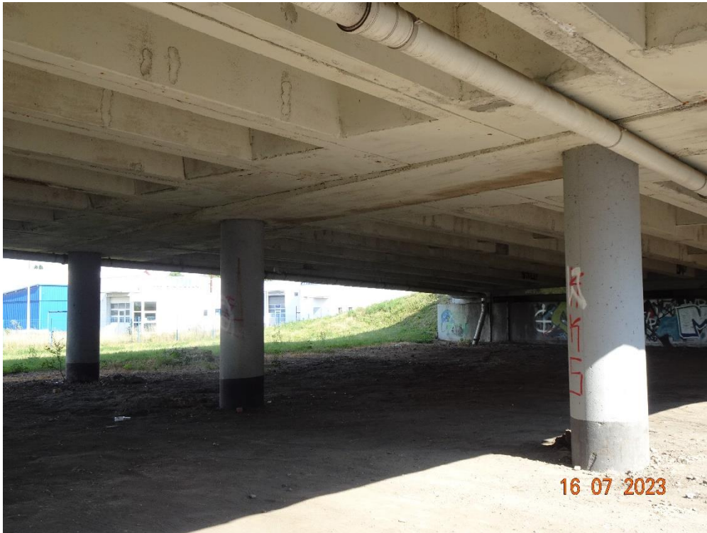
Fot. 15. Podpora nr 2.
