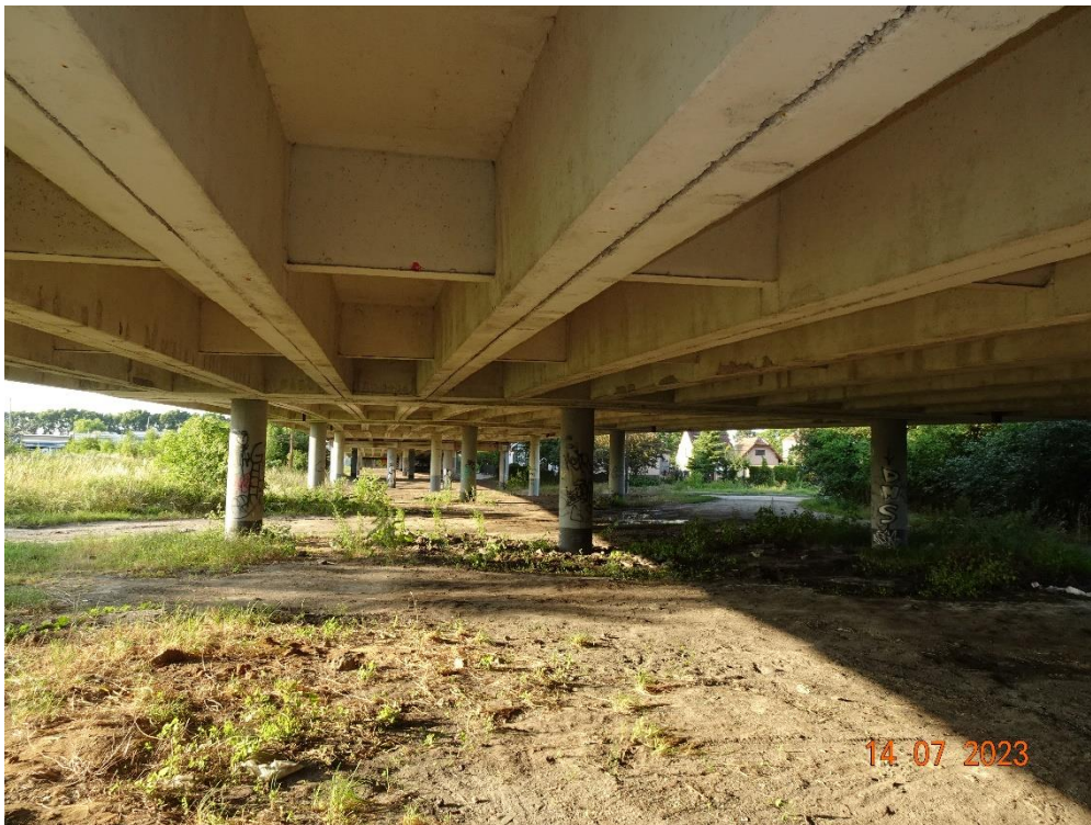
Fot. 21. Podpora nr 8.
