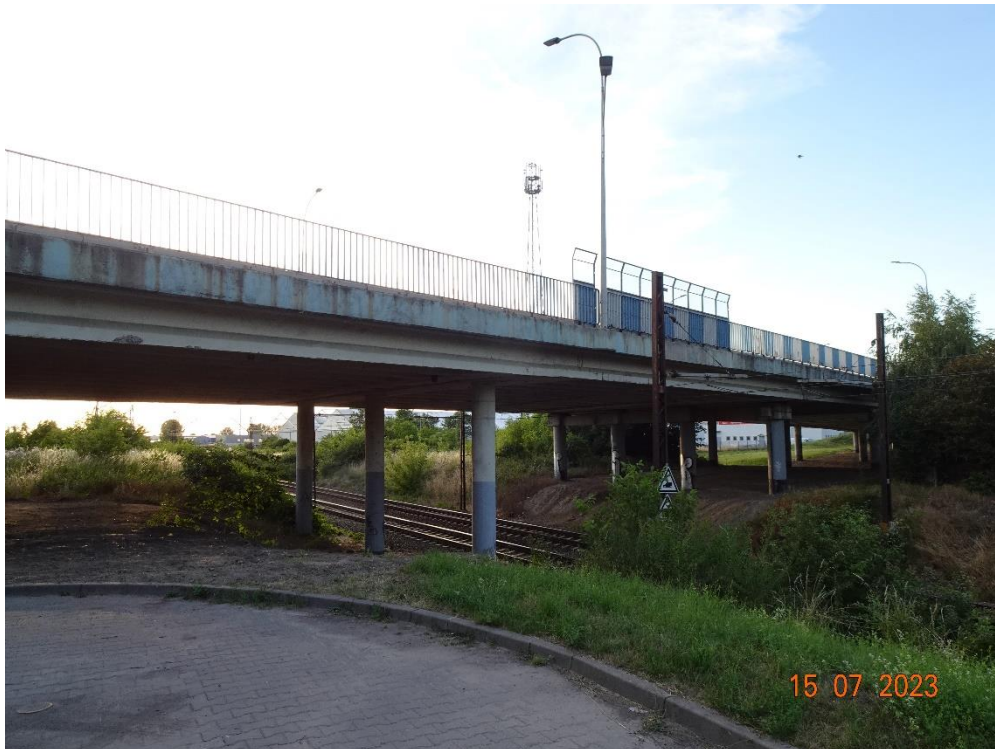
Fot. 5. Widok obiektu z boku od strony wschodniej (strona lewa), widok przeszkody (linia kolejowa E20).
