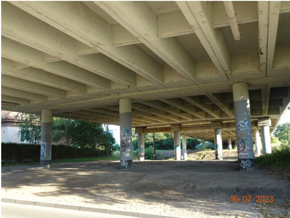
Fot. 17. Podpora nr 4.
