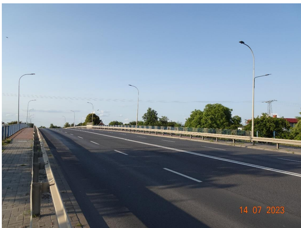
Fot. 30. Widok dojazdu od strony południowej.
