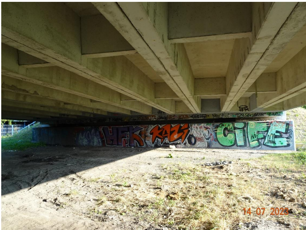
Fot. 6. Spód przęsła 8-9, przyczółek nr 9.
