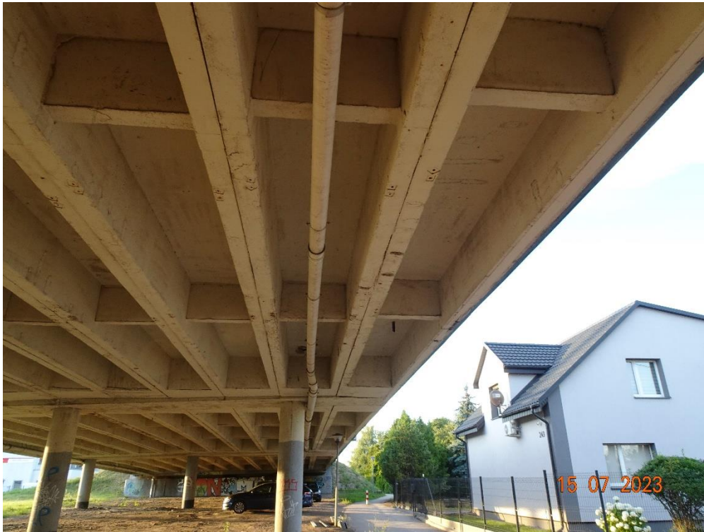
Fot. 11. Spód przęseł 2-3 oraz 3-4.
