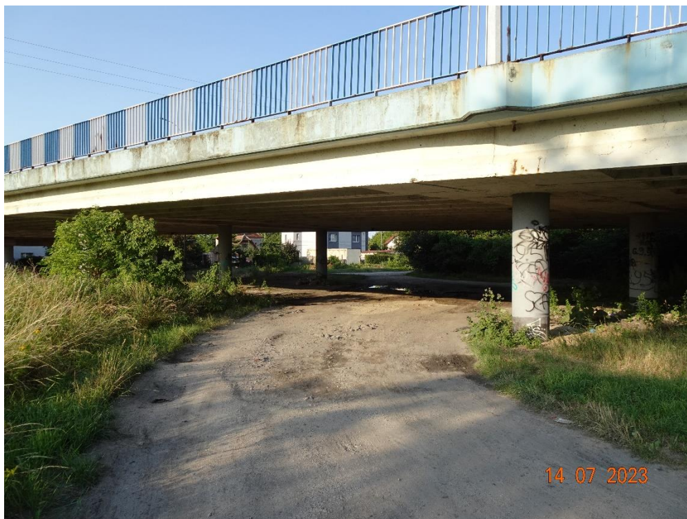
Fot. 27. Widok przeszkody – dojazd technologiczny, widok od wschodu.
