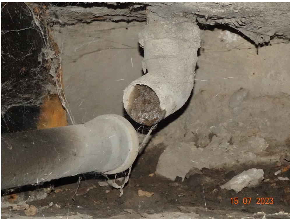
Fot. 80. Uszkodzenie połączenia rury odprowadzającej wodę z sączka przy podporze nr 1.
