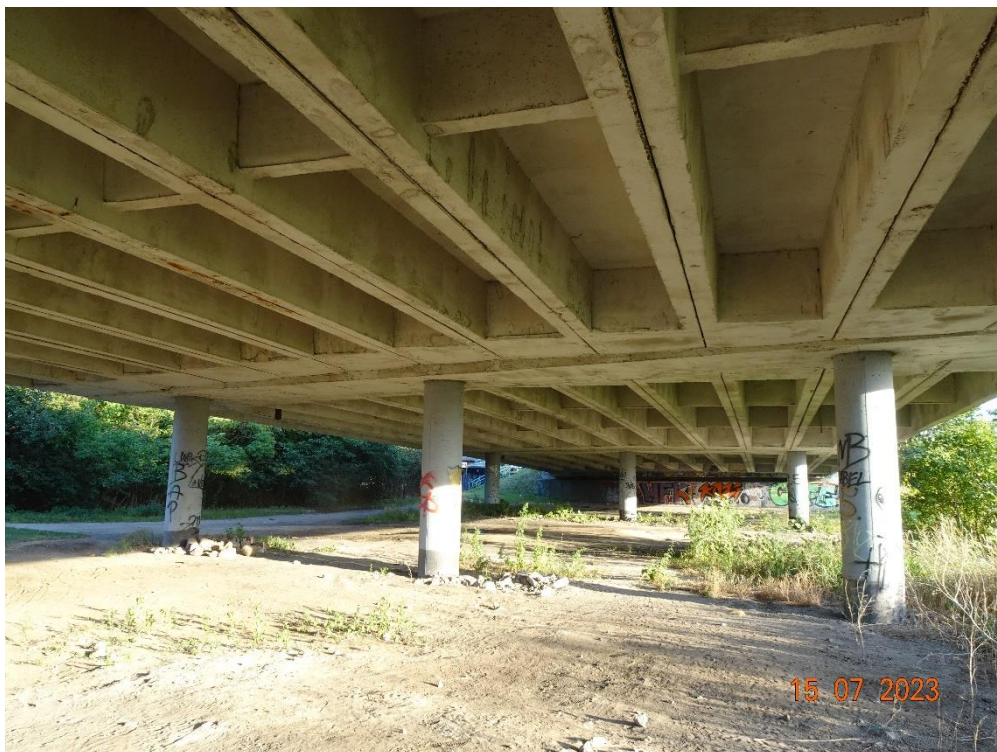
Fot. 20. Podpora nr 7.
