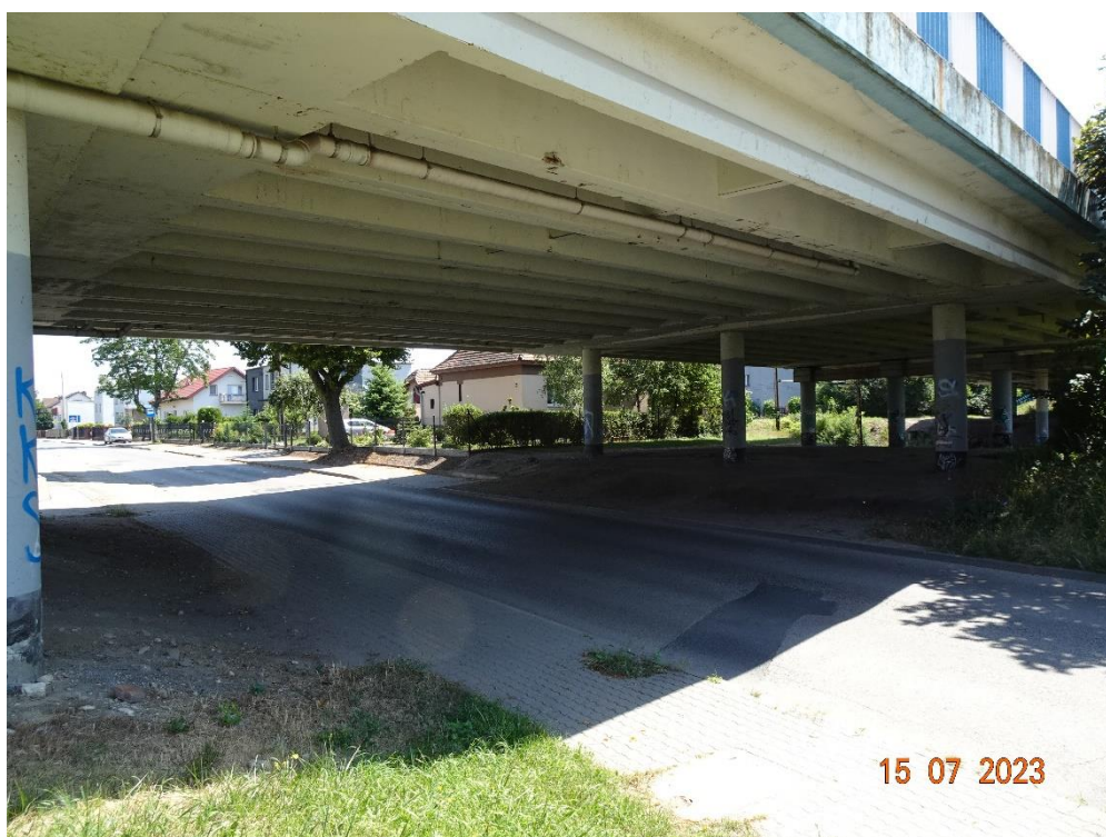
Fot. 28. Widok przeszkody – ul. Przybyszewskiego, widok od wschodu.
