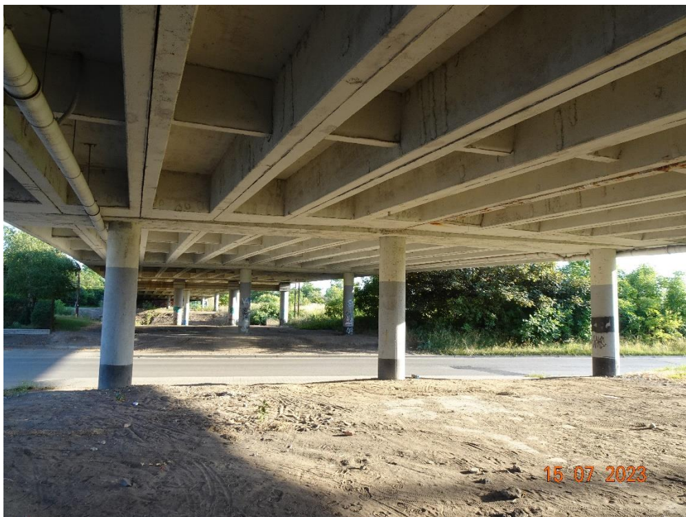
Fot. 16. Podpora nr 3.
