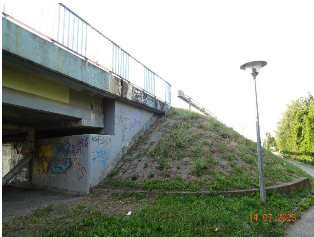
Fot. 23. Stożek skarpowy przy przyczółku nr 1, strona wschodnia.
