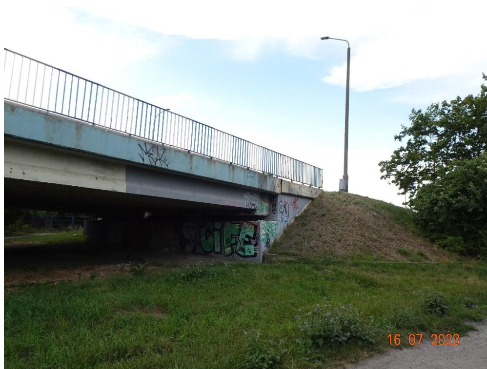
Fot. 24. Stożek skarpowy przy przyczółku nr 9, strona zachodnia.
