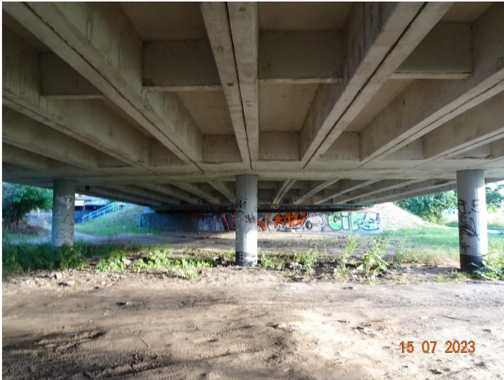
Fot. 7. Spód konstrukcji (przęsła 7-8 i 8-9), filar nr 8, przyczółek nr 9.
