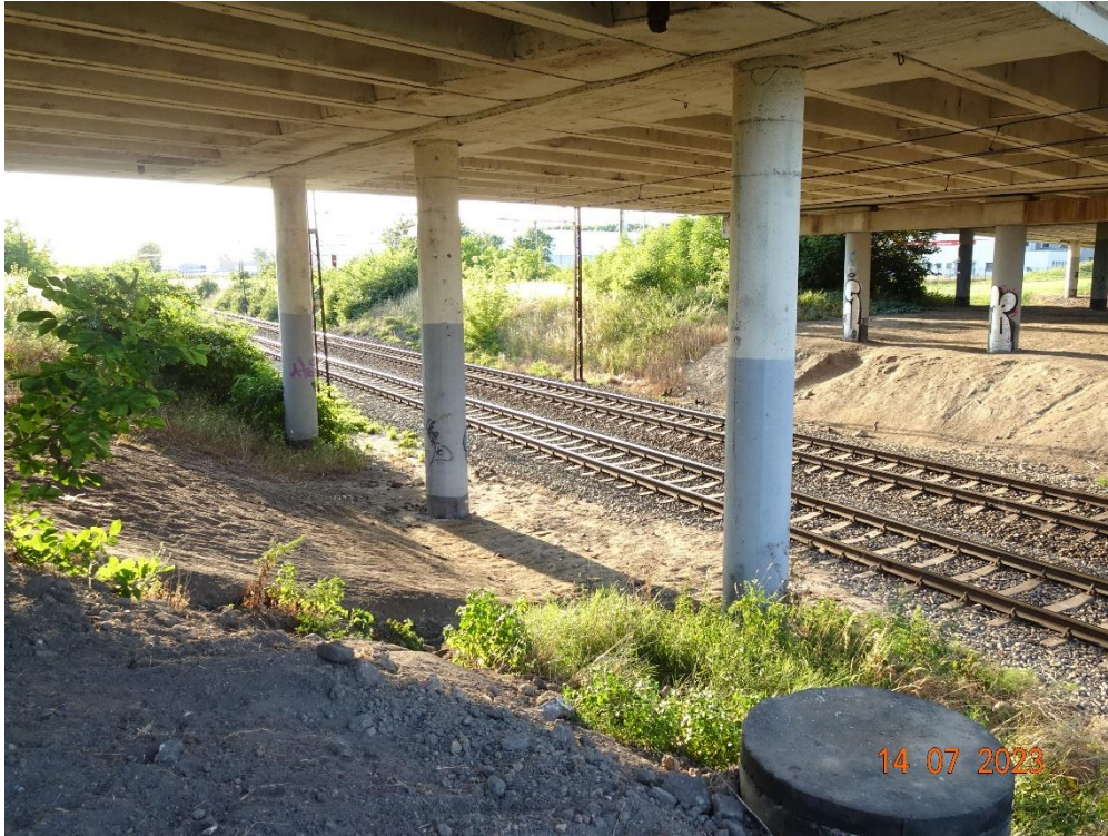
Fot. 19. Podpora nr 6.
